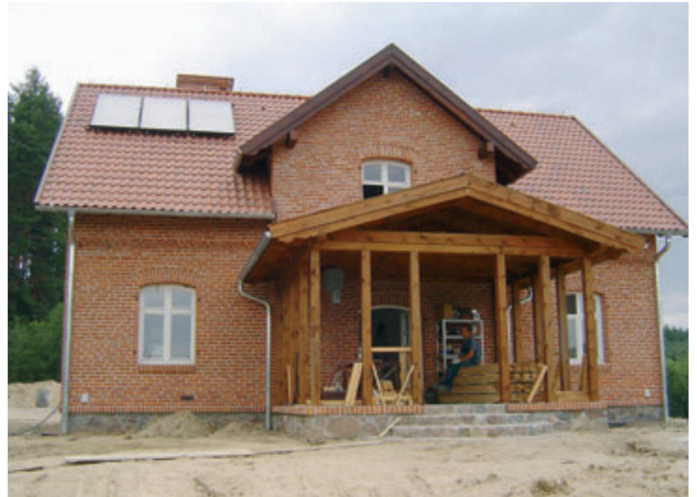
Prawidłowo działająca instalacja solarna pokrywa nawet 50 proc. całkowitego zapotrzebowania na energię do ogrzewania wody użytkowej Fot. Elektro-Sanit
