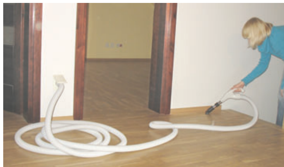
Sprzątanie w domu z systemem centralnego odkurzania odbywa się w ciszy i bez konieczności przeciągania za sobą całego urządzenia Fot. Elektro-Sanit
